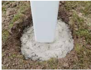
Schritt 2: Beton in Erdreich
